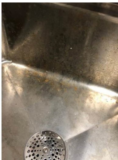
Visar en disklåda där användaren missat utföra underhåll.
