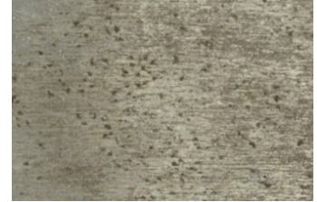
Visar en rostfri plåt som har angripits av korrosion.
